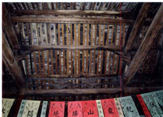
图三 西坑村明代祖宗宫梁架结构
